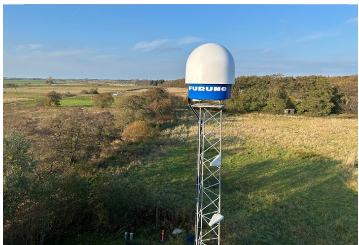
Figur 8 Viser Aalborg Forsynings x bånd radar - WR-2120.
